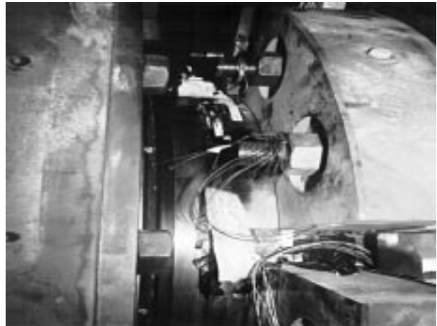
Bild 7: Applizierte Meßtechnik auf der Gutbettwalzenmühle vor der Inbetriebnahme
