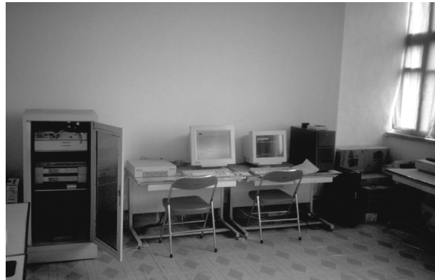
Bild 3: Blick auf den zentralen LAN-Schrank, daneben der Unix- und NT-Server.
