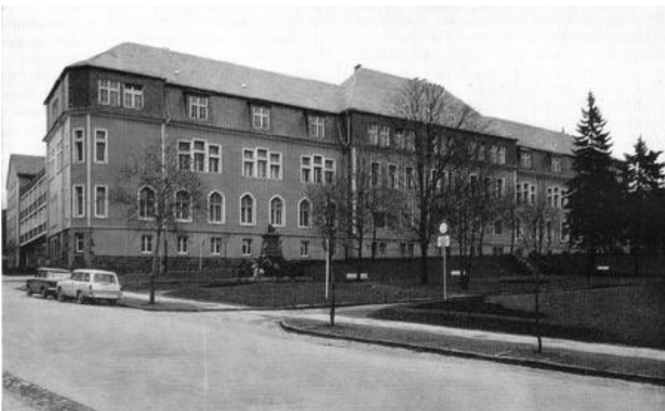
Bild 11: Hauptgebäude der Bergakademie am Hindenburgplatz nach dem Umbau 1965
