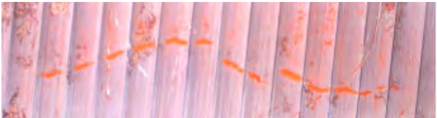
Abbildung 2: Mittels magnetischer Prüfung erfasstes Rissbild
